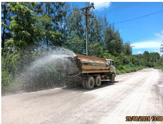
รูปที่ 3-11 ฉีดพรมน้ำตามเส้นทางขนส่งแร่
